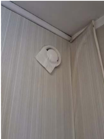
Avtrekkseffekten er testet med papir.
