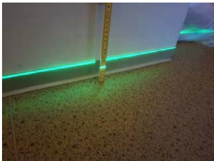
Etasjeskille er kontrollert med nivelleringslaser.
