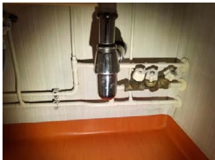
Synlige vannrør av kobber.
