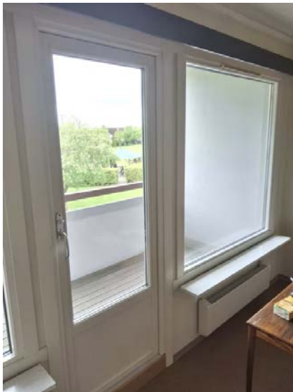
Leiligheten har vinduer og balkongdør med karmen av tre og to-lags glass.
