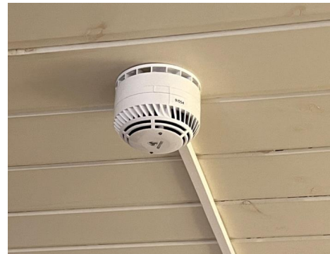
En av to seriekoblede røykvarslere
