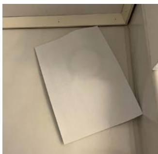
Avtrekksventil bestod papirtesten
