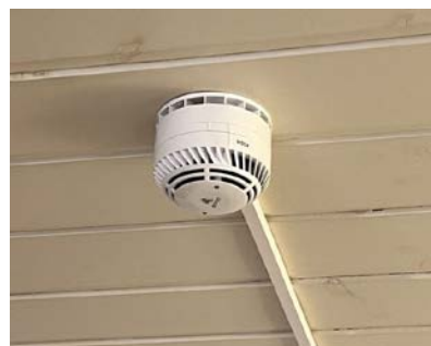
En av to seriekoblede røykvarslere
