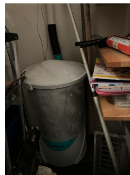
Sentralstøvsuger i teknisk rom.
