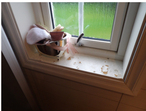
Vindu i dusjsone.
