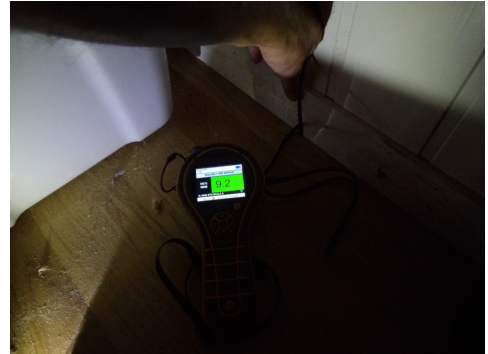
Ingen unormale fuktverdier registrert.
