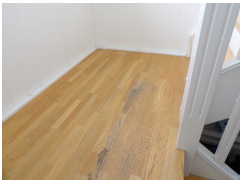
Slitasje på overflater i repo.
