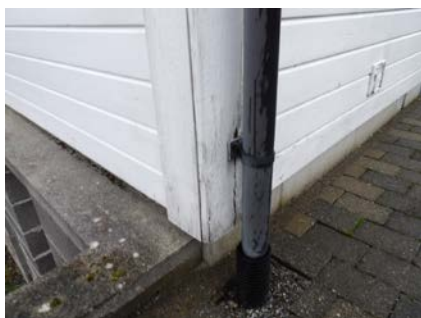
Råteskade og oppsprekk på hjørnebord.
