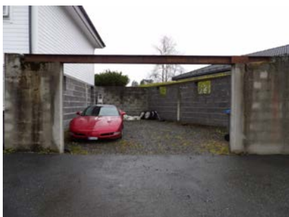
Støpt grunnmur til garasje.
