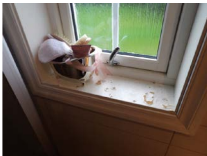
Vindu i dusjsone.
