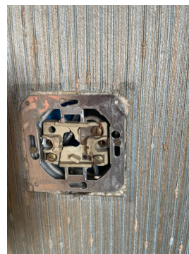
Bryter på soverom, berøringsfare
