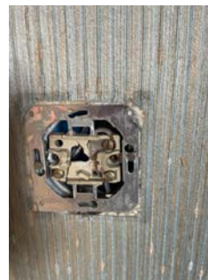
Bryter på soverom, berøringsfare
