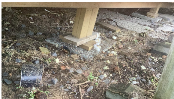
Eksempel på fundamentering av tilbygget del.
