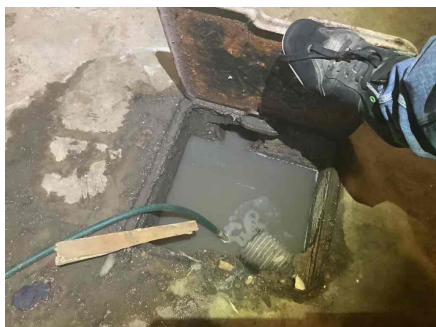
Grube i gulv i vaskekjeller.
