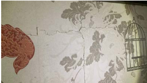
Eksempel på rift i tapet.
