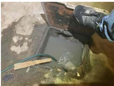
Grube i gulv i vaskekjeller.
