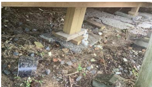
Eksempel på fundamentering av tilbygget del.
