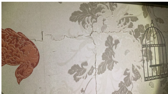
Eksempel på rift i tapet.
