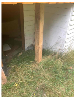
Eksempel på fundamentering av tilbygget del.
