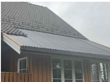
Det er benyttet takstein og takplater av metall.
