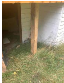
Eksempel på fundamentering av tilbygget del.
