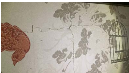
Eksempel på rift i tapet.
