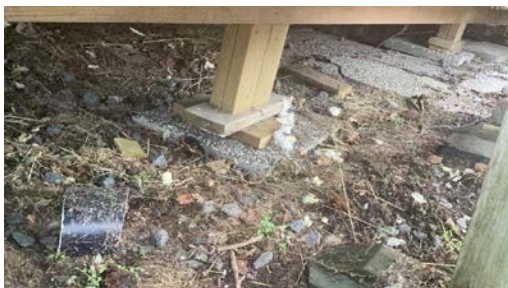
Eksempel på fundamentering av tilbygget del.
