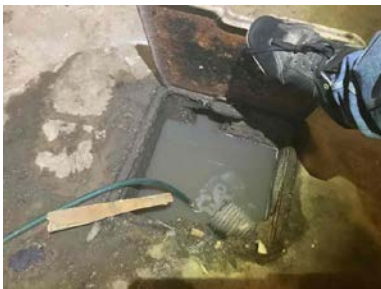
Grube i gulv i vaskekjeller.
