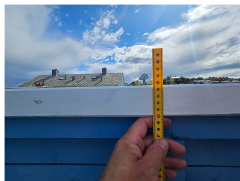
Rekkverk målt til ca. 95 cm.
