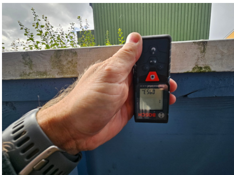
Rekkverk målt til ca. 95 cm.
