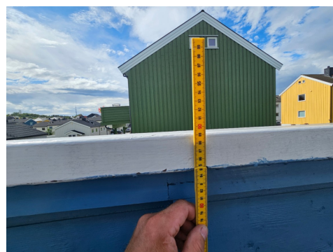
Rekkverk målt til ca. 89 cm.
