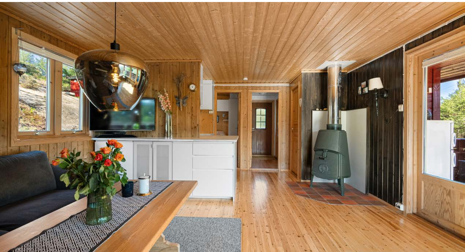
Varmepumpe og ildsted/vedovn i stuen. Innlagt strøm, vann og avløp
