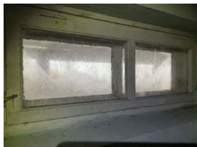
Dugg på vinduets innside tyder på manglende ventilasjon.
