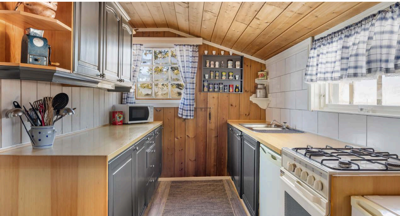
Furukjøkken med malte profilerte fronter, laminert benkeplate med nedfelt kum og fliser i benkeryggen. Vann fra vannbeholder med elektrisk pumpe og avløp med rør ut til terreng.
