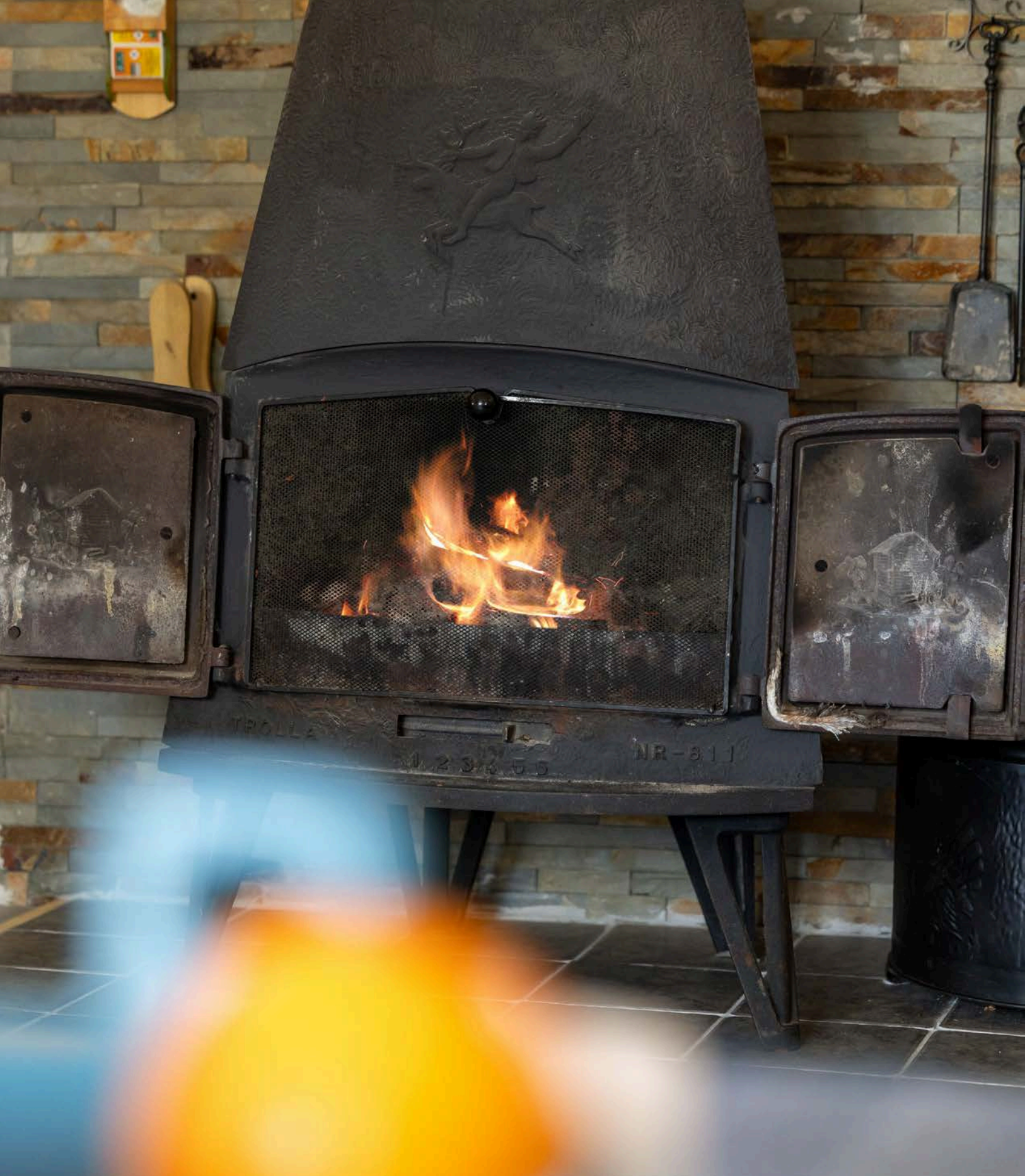
Det er innlagt strøm i 2012, montert solcellepanel og vedfyring med peisovn i stuen.
