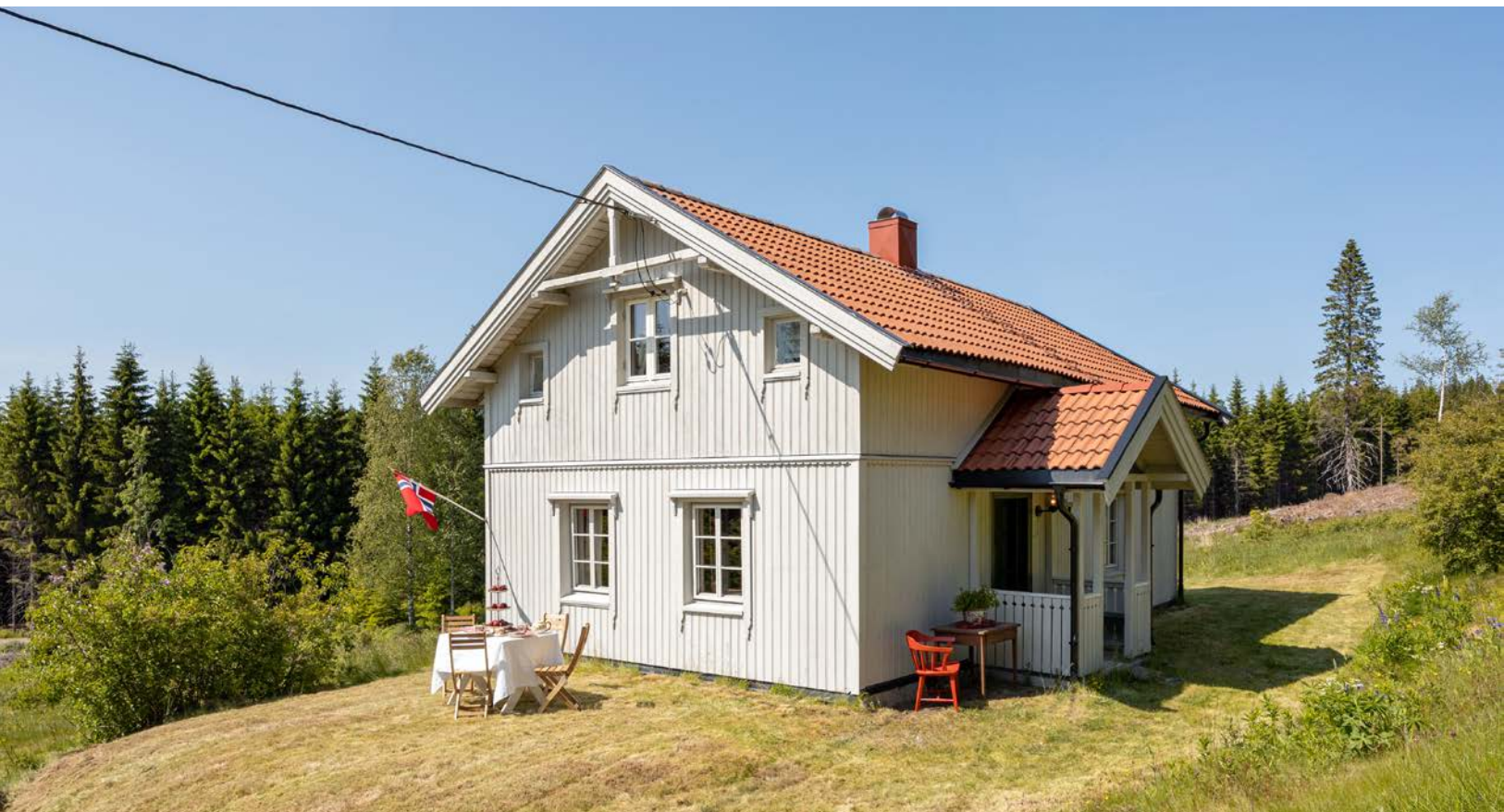
Hytta har et tiltalende inngangsparti med overbygg, adkomst repos, rekkverk på begge sider og en utelampe montert ved siden av inngangsdøren.
