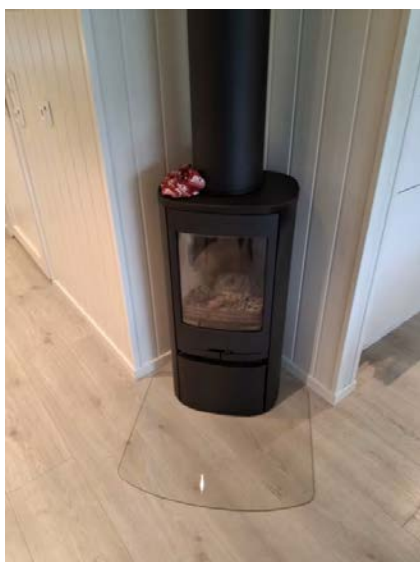
Vedovn med glassdør i stue.
