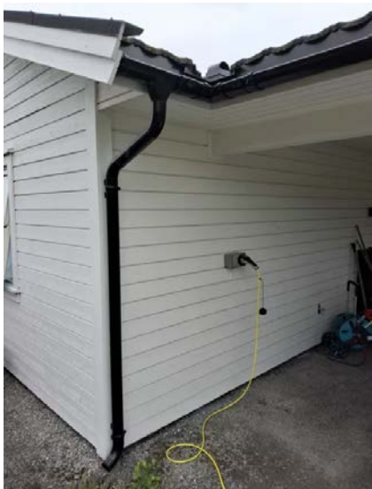
Boligen har takrenner og nedløpsrør av metall.
