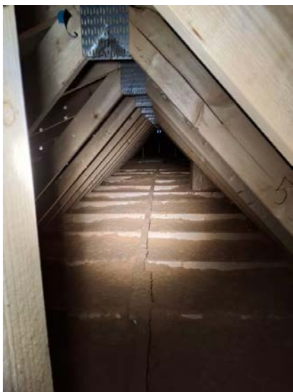
Boligen er oppført med kaldtloft.
