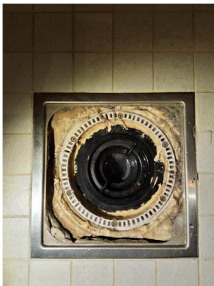
Ingen avvik avdekket i overgang membran/sluk.
