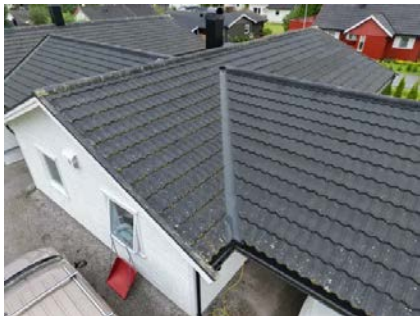
Taket er tekket med metallplater.
