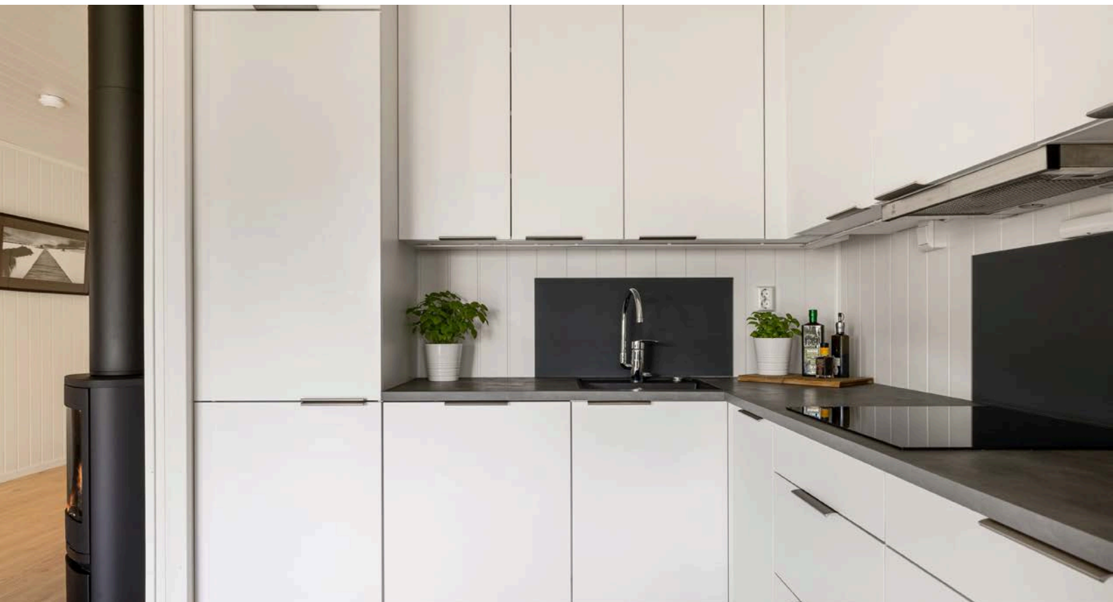
Bak kum og platetopp er det montert glassplate for å beskytte veggen mot vann og søl.
