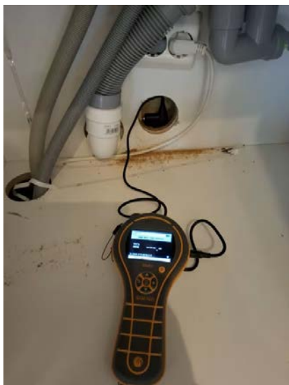
Bilde fra fuktmåling i veggkonstruksjon tilstøtende våtsone.
