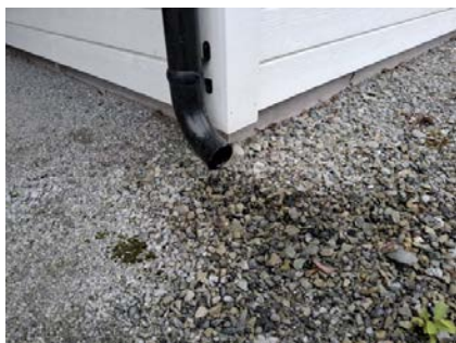
Taknedløp er avsluttet over bakken med utkast.
