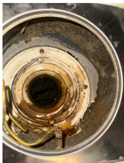
Hovedsluk med klemring for membran
