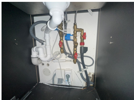
Rørapplegg i kjøkkenbenk med Waterguard
