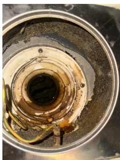
Hovedsluk med klemring for membran
