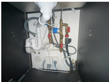
Røropplegg i kjøkkenbenk med Waterguard
