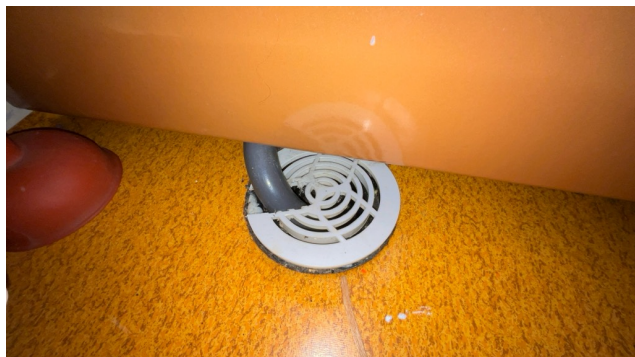
Kontroll av sluk.
