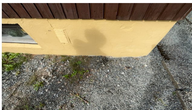
Kontroll av drenering/fuktsikring.
