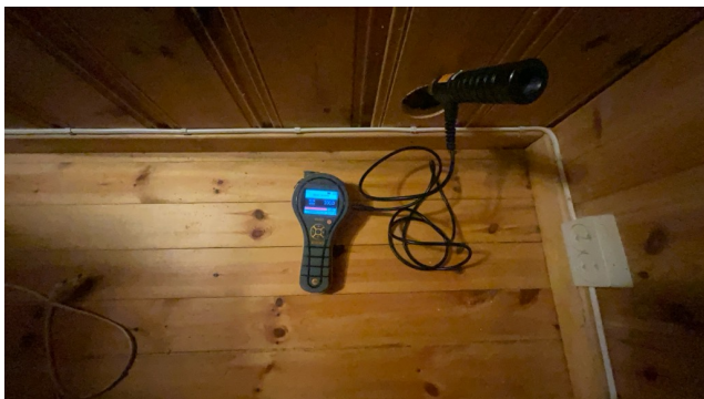
Utført hulltaking på rom under terreng.
