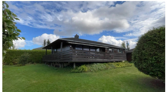
Besiktigelse av taktekke.
