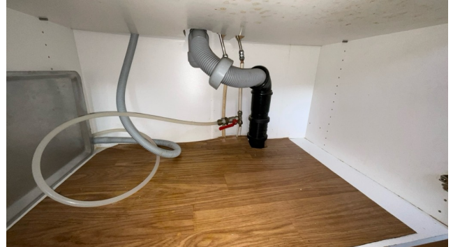
Besiktigelse av røropplegg.
