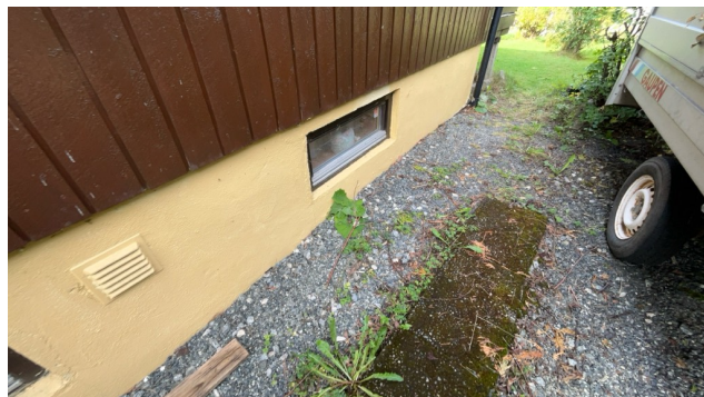
Kontroll av drenering/fuktsikring.
