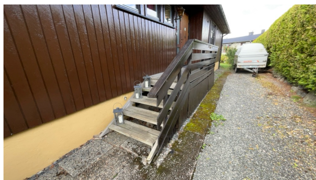
Besiktigelse av trapp.
