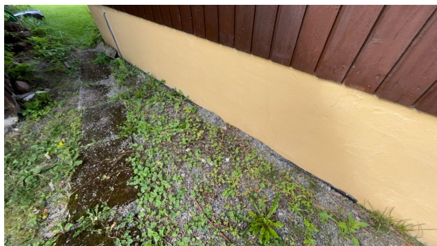
Kontroll av drenering/fuktsikring.
