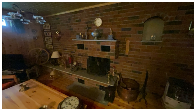
Besiktigelse av ildsted.
