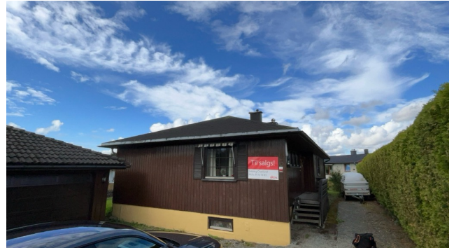
Besiktigelse av taktekke.
