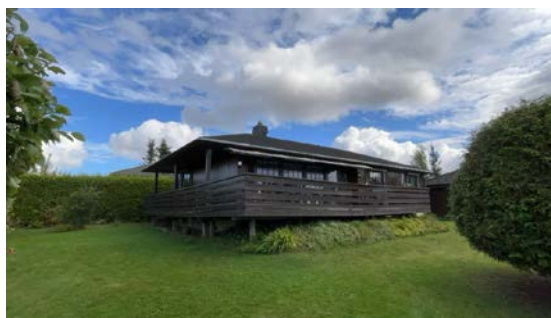
Besiktigelse av taktekke.
