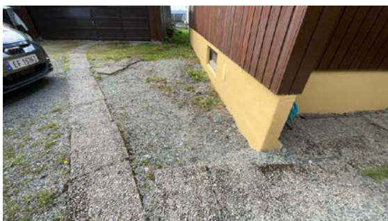
Det er påvist dårlig fall eller flatt terreng inn mot grunnmur og dermed muligheter for større vannansamlinger.
