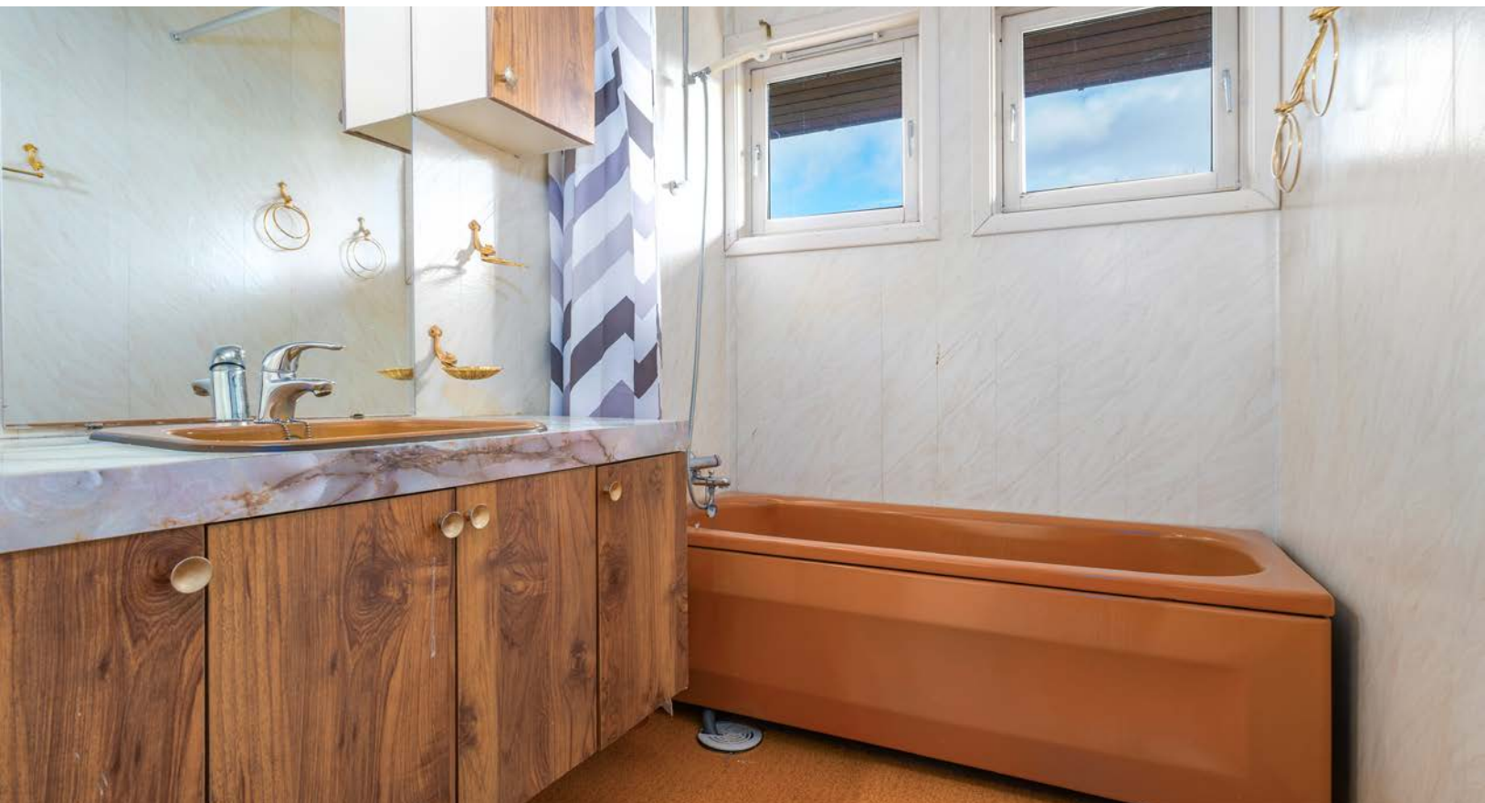
Baderom med våtromsplater på vegg og belegg på gulv.
