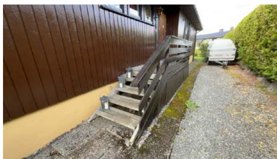
Besiktigelse av trapp.
