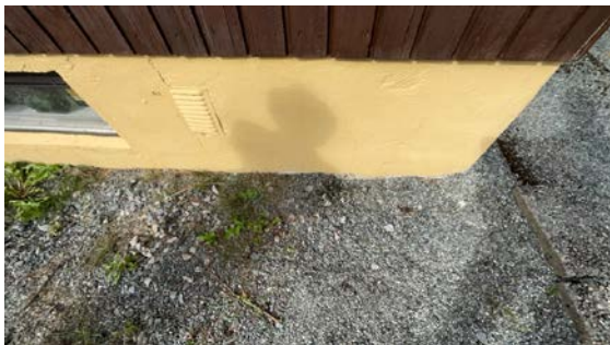
Kontroll av drenering/fuktsikring.
