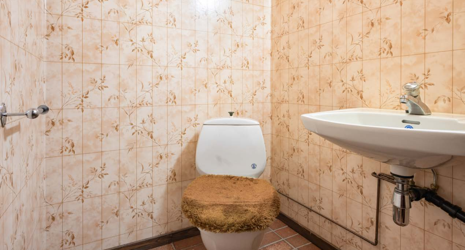
Wc-rom med klosett og servant.
