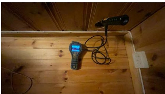
Utført hulltaking på rom under terreng.
