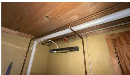
Besiktigelse av røropplegg.
