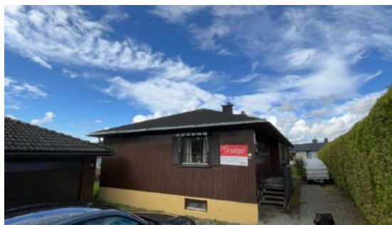
Besiktigelse av taktekke.
