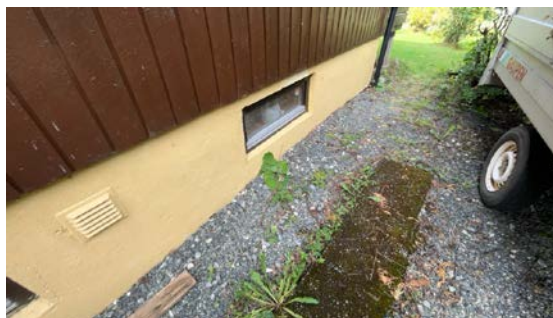
Kontroll av drenering/fuktsikring.
