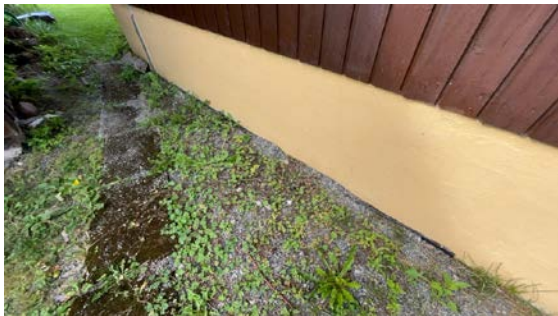
Kontroll av drenering/fuktsikring.
