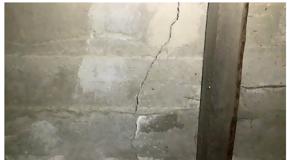
Eksempel på innvendig skråriss.
