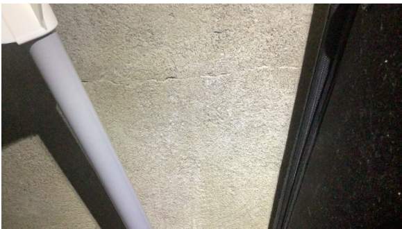
Eksempel på innvendig horisontalriss.
