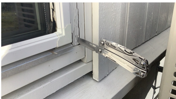
Råteskadet vindu.
