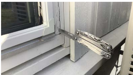
Råteskadet vindu.
