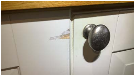
Eksempel på slitasje.
