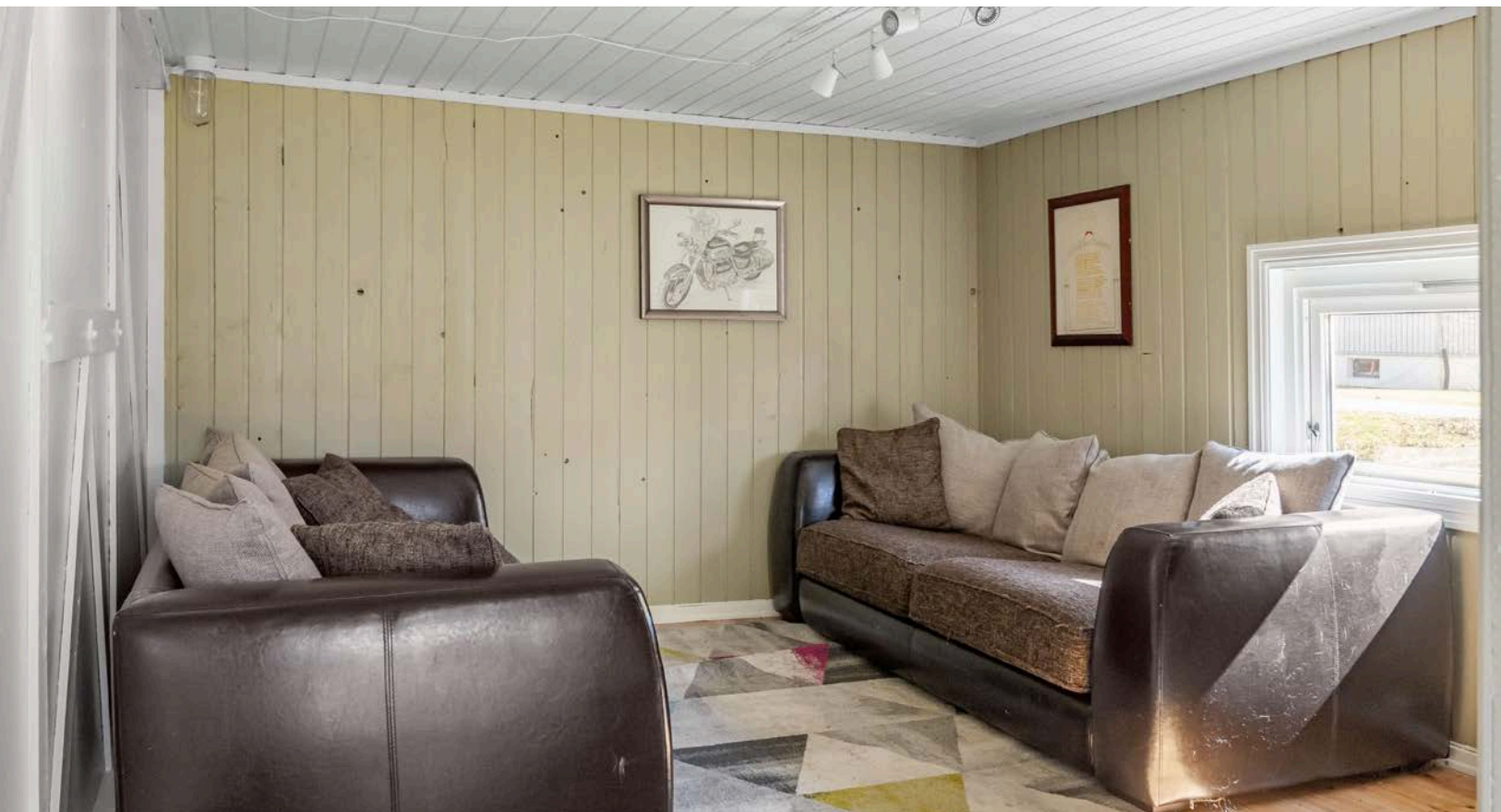
Innvendige vegger er kledd med malt panel, og gulvet består av lakkert heltregulv.
