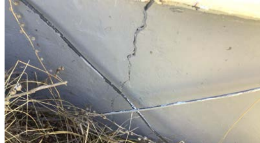
Eksempel på utvendig skråriss.
