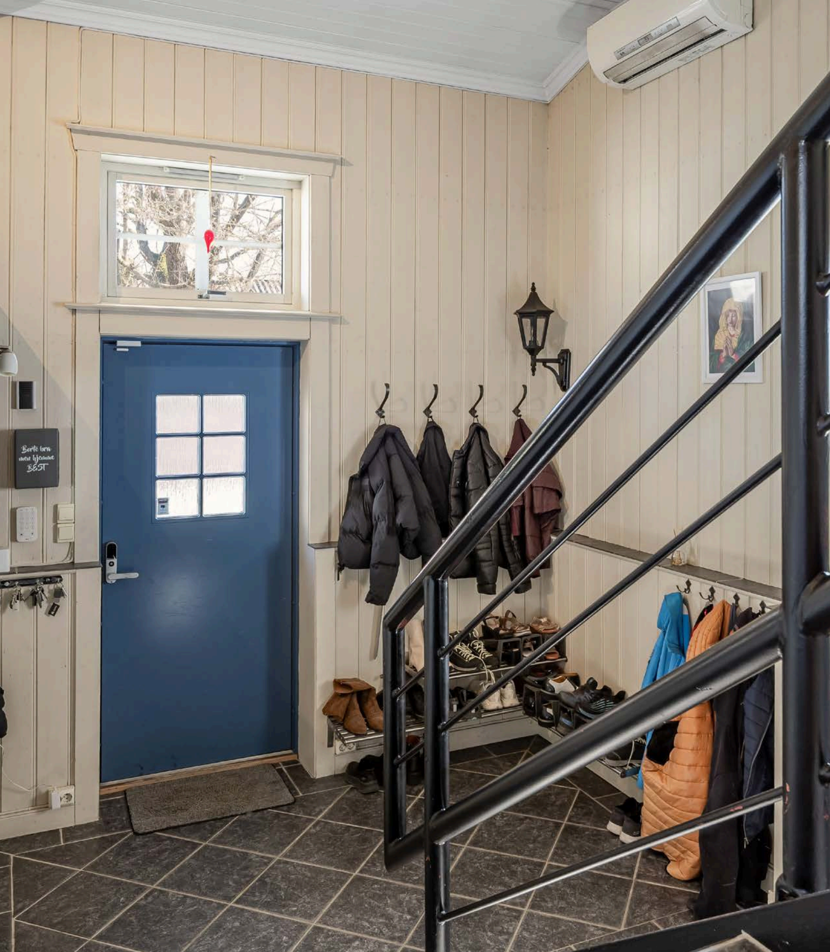
Hallen har flislagt gulv og lysmalte panelvegger. Vannbåren gulvvarme er installert.
