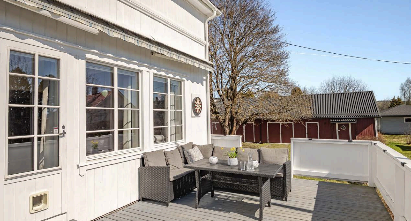
Sørvendt treterrasse med adkomst fra stuen. Tett rekkverk kledd med stående bordkledning, så her sitter du skjermet og fint til i solveggen.
