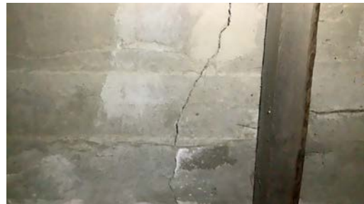
Eksempel på innvendig skråriss.
