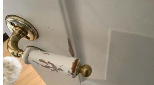
Eksempel på slitasje på dør.
