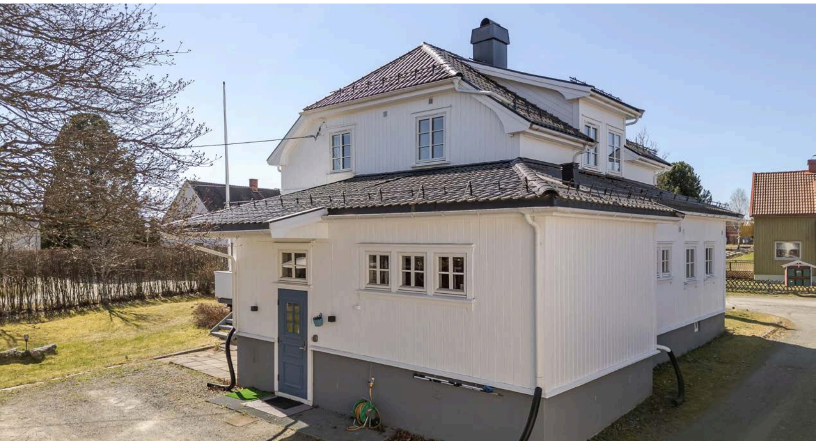
I 1999 ble boligen renoverert utvendig og innvendig.
