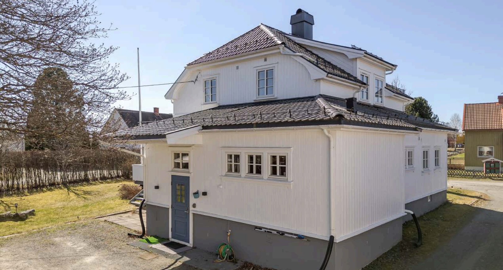
I 1999 ble boligen renoverert utvendig og innvendig.
