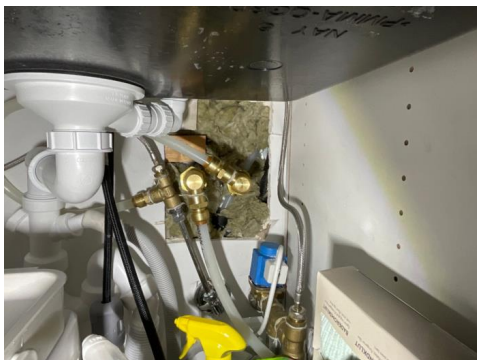
Rør under kjøkken
