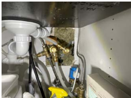
Rør under kjøkken
