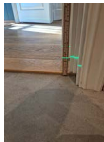
...til 59 mm ved dør, som er et motfall på 9 mm.
