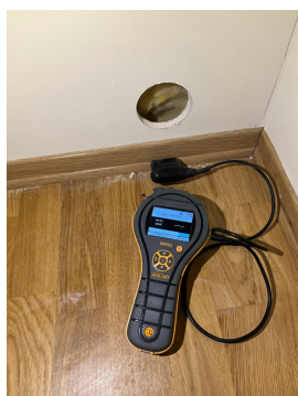
Fuktmåling i gulvlist ved hulltaking.
