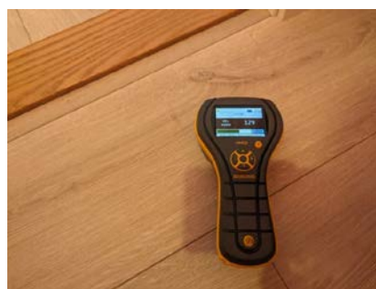
Fuktsøk på gulv uten påviste indikasjoner/avvik
