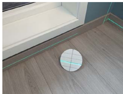
Måling av skjevhet/retningsavvik på gulv i stue
