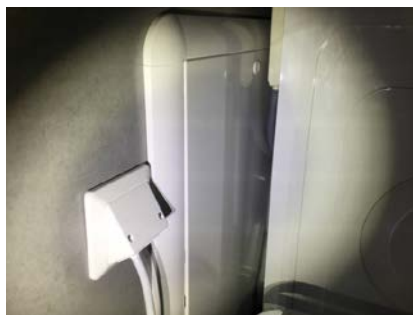
Fordelerskap for rør-i-rør
