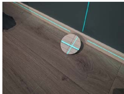
Måling av skjevhet/retningsavvik på gulv i soverom
