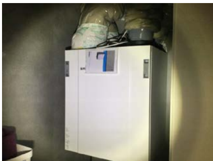
Ventilasjonsaggregat
