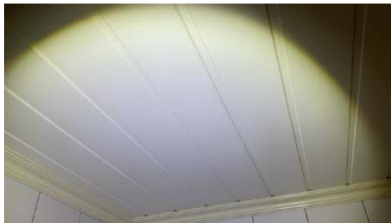
Svelleskader i himlingspanel.
