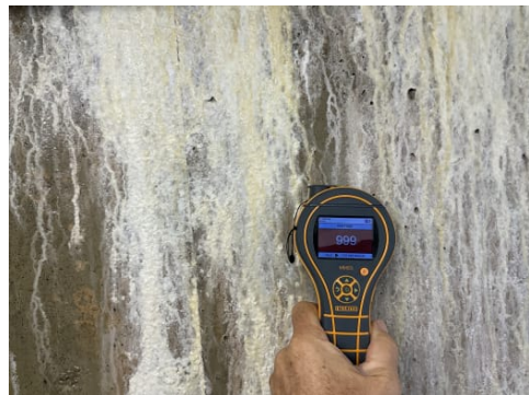
Vegg i boden i 2. etasje.
