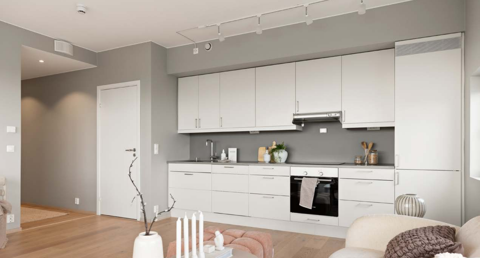
I himlingen er det montert downlights og spotter
