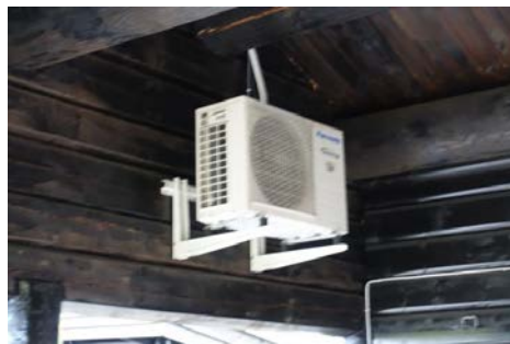
Utv. aggregatdel til luft til luft varmepumpen.
