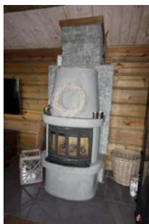
Peis med støpejernsinnatts i stue.
