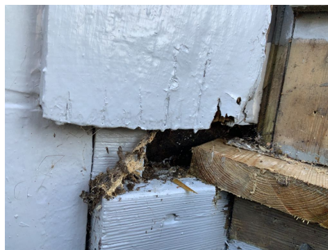
Åpning i ytterpanel for innfesting av terrasse.
