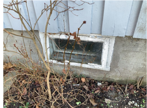
Vindu i kjeller råteskader
