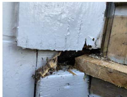
Åpning i ytterpanel for innfesting av terrasse.
