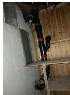
Soilrør/støpejern innvendig og delvis ut.
