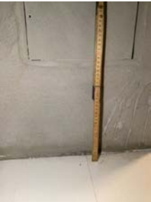
Ildfast plate under sotluke kreves der avstand er mindre enn 300m til brennbart materiale på gulv.
