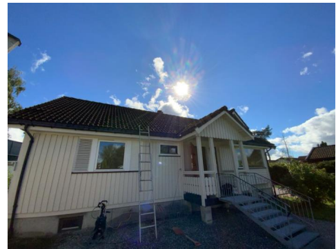
Besiktigelse av taktekke.
