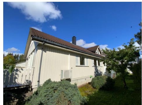
Besiktigelse av taktekke.
