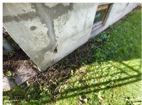
Kontroll av drenering/fuksikring.
