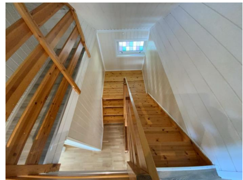
Besiktigelse av trapp.
