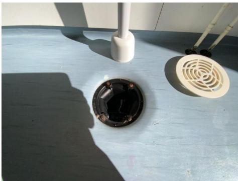
Kontroll av sluk.
