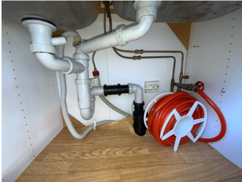
Besiktigelse av røropplegg.
