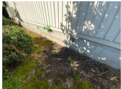
Kontroll av drenering/fuksikring.
