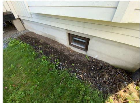
Kontroll av drenering/fuksikring.
