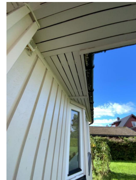
Synlige luftespalter i gesimskasse.
