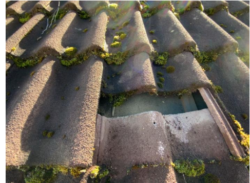
Kontroll av undertak.
