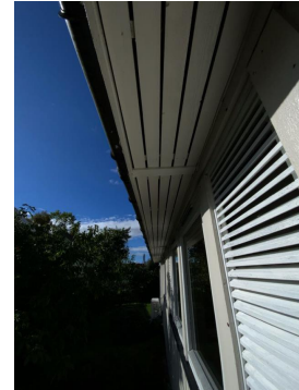
Synlige luftespalter i gesimskasse.
