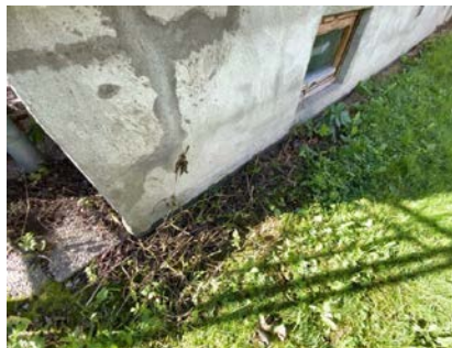
Kontroll av drenering/fuktsikring.
