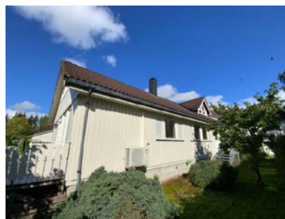
Besiktigelse av taktekke.
