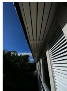
Synlige luftespalter i gesimskasse.
