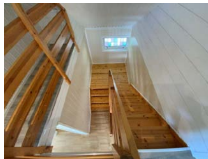
Besiktigelse av trapp.
