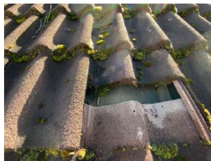
Kontroll av undertak.
