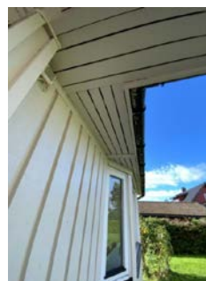
Synlige luftespalter i gesimskasse.
