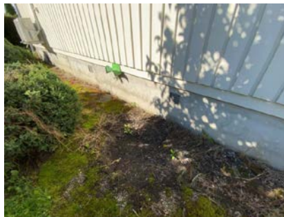
Kontroll av drenering/fuktsikring.
