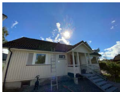
Besiktigelse av taktekke.
