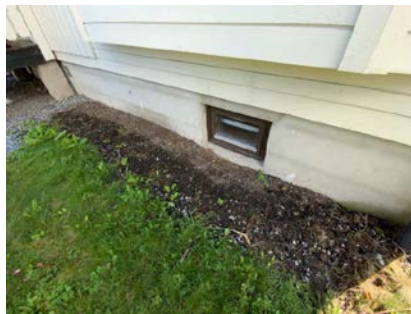
Kontroll av drenering/fuktsikring.
