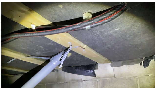
Undersiden av baderommet.
