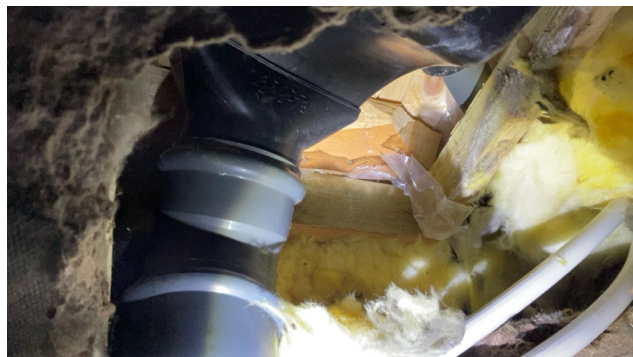
Sluket sett fra undersiden av vaskerommet.
