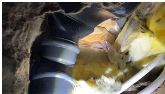
Sluket sett fra undersiden av vaskerommet.
