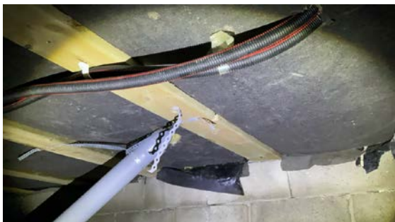
Undersiden av baderommet.
