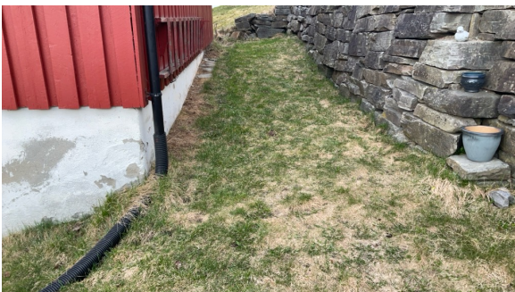
Fall på terreng mot grunnmur.
