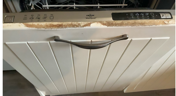
Fukt på front til oppvaskmaskin
