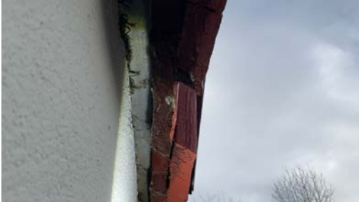
Kun lufting av konstruksjonen under overbord.
