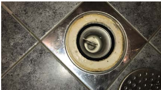
Bilde viser sluk 2.ETG. > BAD.
