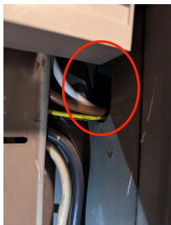
Manglende tetting/beskyttelse rundt kabler i gjennomføring i skap.
