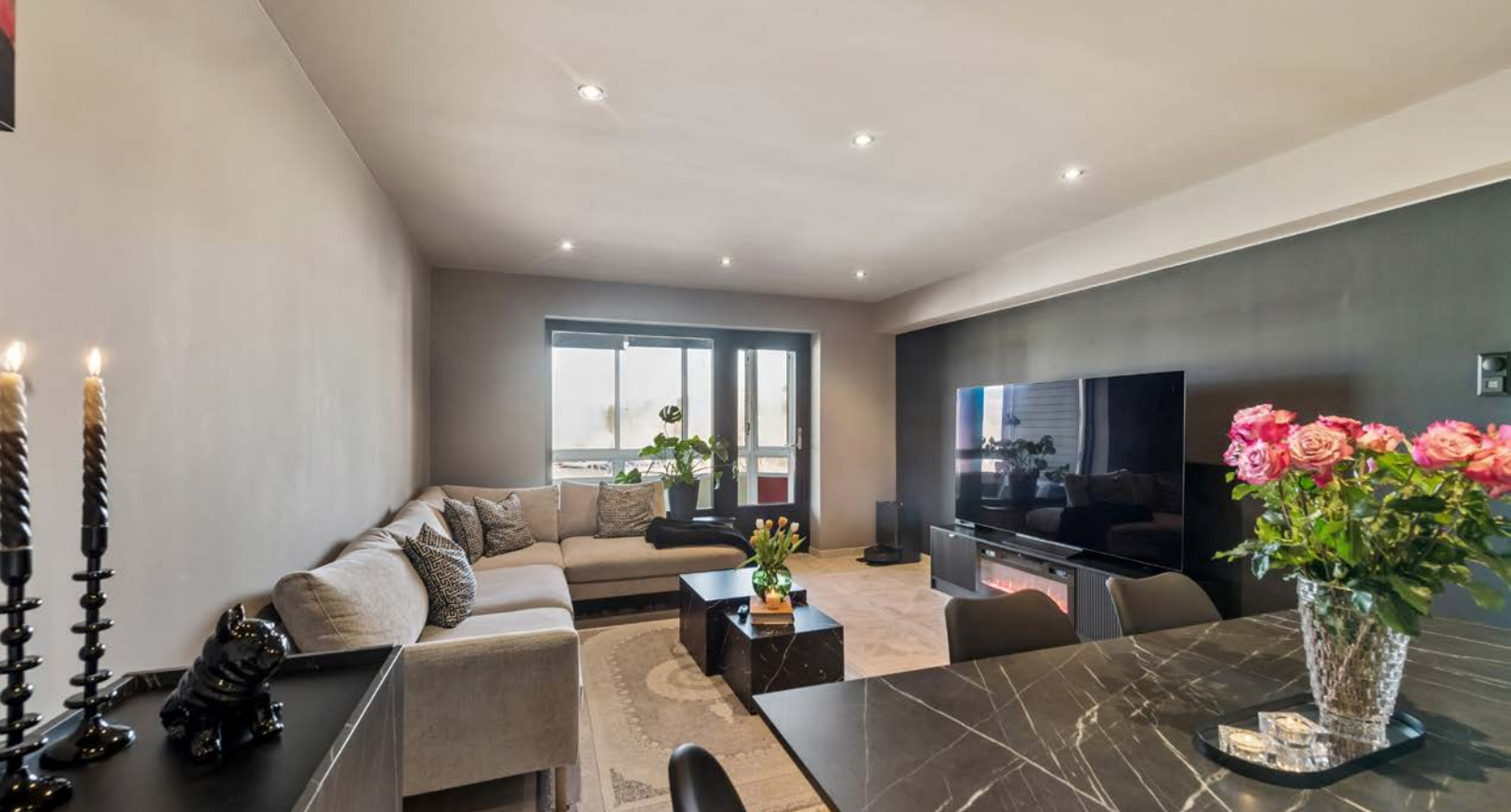
Det er listefritt rundt vinduet og i overgang vegg/tak.
