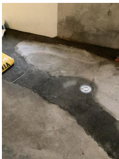
Gulvet i kjeller er pigget opp for å legge ny vannledning og avløp.
