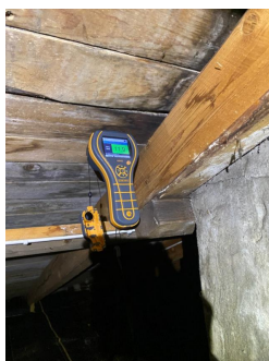
Normale verdier ved fuktmåling i undertak.
