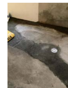
Gulvet i kjeller er pigget opp for å legge ny vannledning og avløp.
