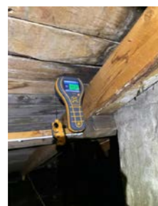
Normale verdier ved fuktmåling i undertak.
