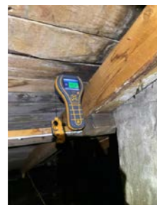
Normale verdier ved fuktmåling i undertak.
